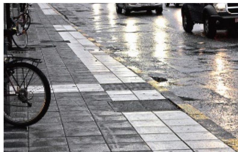
► En las orillas de las banquetas hay una línea de contraste que sirve a los débiles visuales ubicar la distancia de la calle a la avenida.
